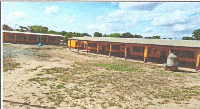
Foto1: IMAGEN QUE MUESTRA LA VISTA FRONTAL DE LA ESCUELA OFICIAL RURAL MIXTA, ALDEA LOS OLIVOS, IXCÁN, QUICHÉ. DONDE SE VA INTERVENIR EL MURO PERIMETRAL.
