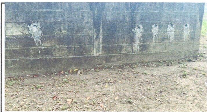
FOTO 5: IMAGEN QUE MUESTRA LOS DAÑOS Y FISURAS QUE SE ENCUENTRAN EN EL MURO PERIMETRAL.
