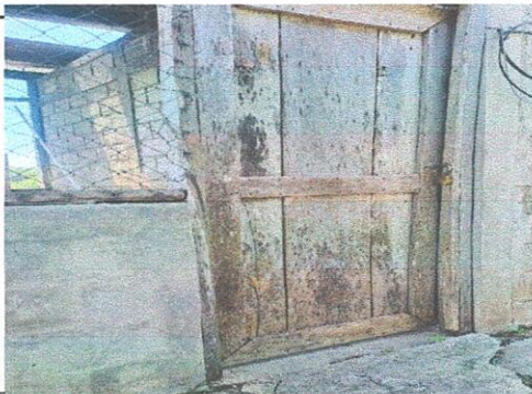
Foto 3: SUSTITUCION DE PUERTA DE MADERA A METAL
