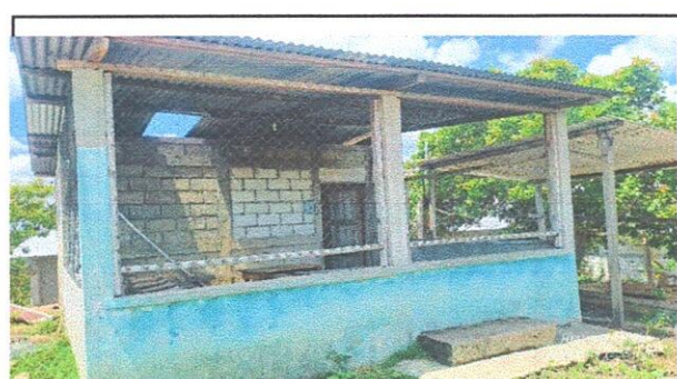
Foto 4: SUSTITUCION DE VENTANAS A BALCONES DE METAL
