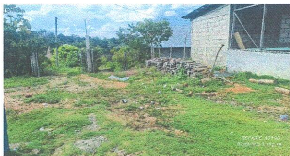
Foto 5: AMPLIACION DE COCINA
