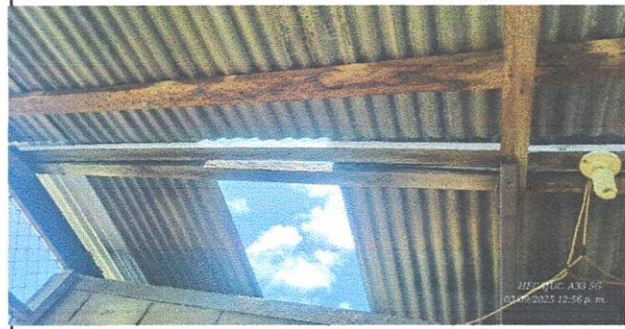
Foto 2: SUSTITUCION DE ESTRUCTURA DE MADERA POR METAL
