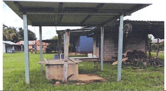
Foto 2: Mejoramiento de pozo artesanal a pozo mecanico.
