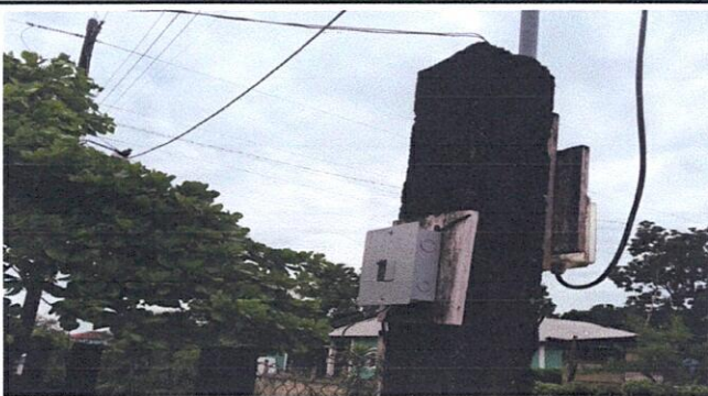
Foto 5: Sustitucion de tablero
