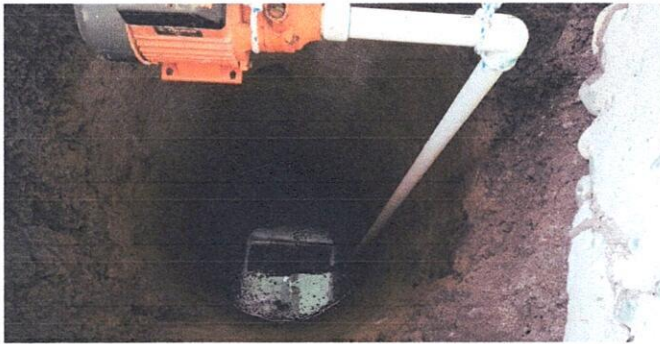
Foto1: Sustitucion de tuberia de PVC Linea Principal.
