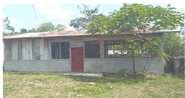
Foto 8: Area de la cocina que se interventa con la instalacion de balcones, su estufa, meseta, reforzamiento de paredes y repello.
