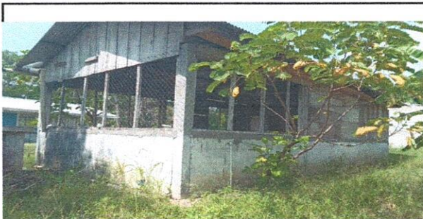
Foto 11: Construcion de pilar de reforzamiento y reconstruccion de muros perimetral de la cocina.
