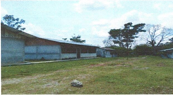
Foto 7: Instalaciones que se necesita pintar que se encuentran en obra gris.
