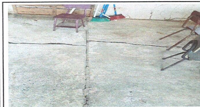
Foto 3: Sustitución de piso de torta de concreto de la cocina.
