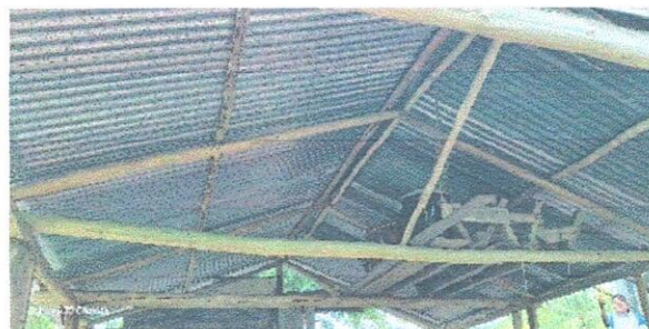
Foto 2: SUSTITUCION DE ESTRUCTURA DE MADERA POR METAL.
