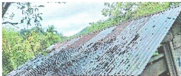
Foto1: SUSTITUCION DE LAMINA POR LAMINA TROQUELADA.
