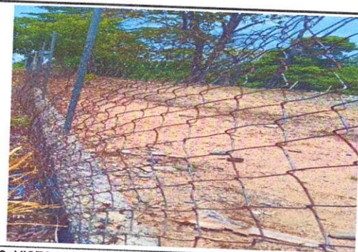
Foto 6: VISTA y TUBOS GALVANIZADOS EN MAL ESTADO.
