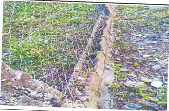
Foto 3: SUMINISTRO DE BLOK PARA PAREDES DE MURO PERIMETRAL.
