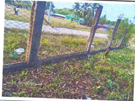
Foto 2: SUMINISTRO DE MAYA PARA MURO PERIMETRAL.
