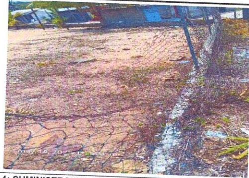
Foto 4: SUMINISTRO DE MAYA PARA MURO PERIMETRAL.
