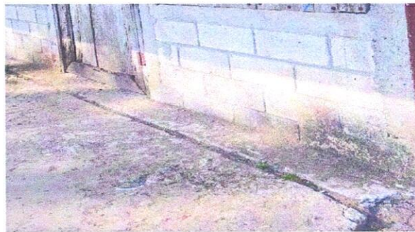
Foto 4: PISO AGRIETADO
