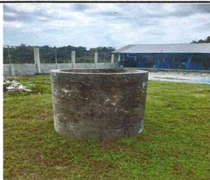
Foto 3: Vista desde la entrada
