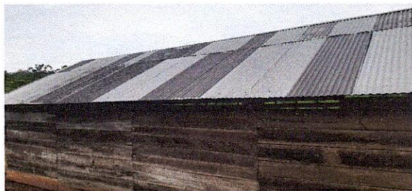
Foto1: Sustitucion de lámina, por lámina troquelada aluzininc calibre 26
