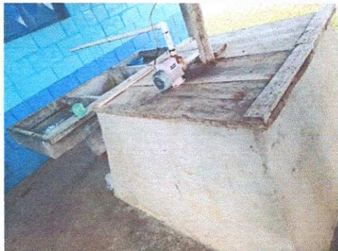
Foto 1: Mejoramiento de pozo artesanal a pozo mecánico
