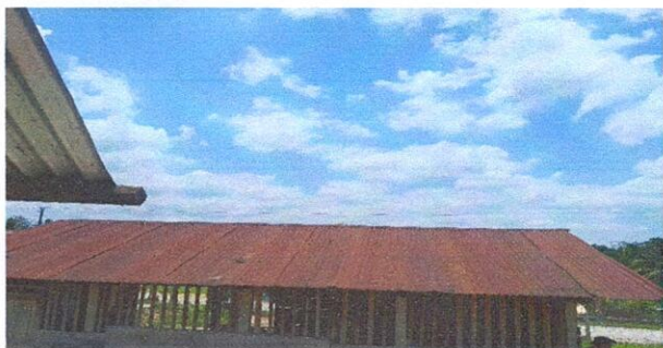
Foto1: Vista frontal del establecimiento y láminas en mal estado
