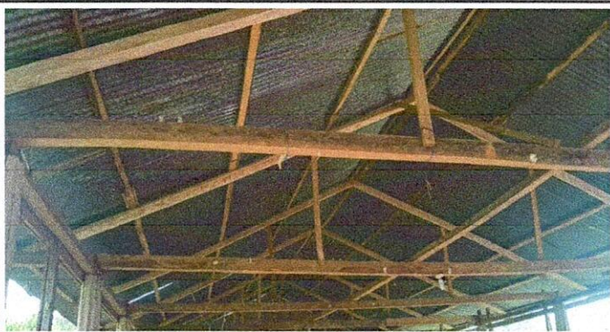
Foto 4: Sustrucción de estructura de madera por metal.
