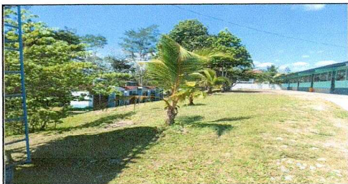
Foto 3: Estructura de deposito de agua
