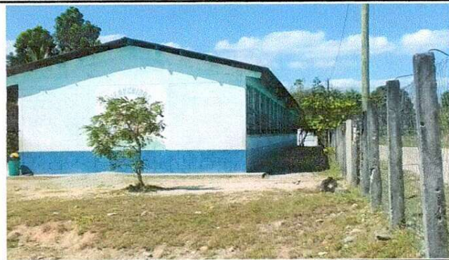
Foto 2: Cubierta de laminas
