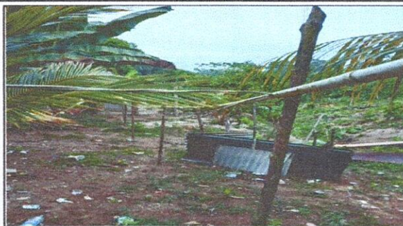
Foto 2: Vista frontal de la tubería del pozo artesanal
