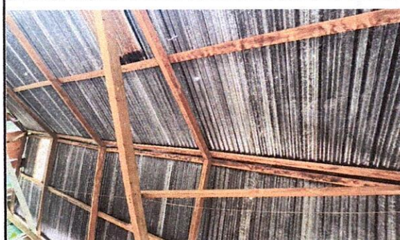
FOTO 2: Sustrucción de soporte de estructura de madera por metal
