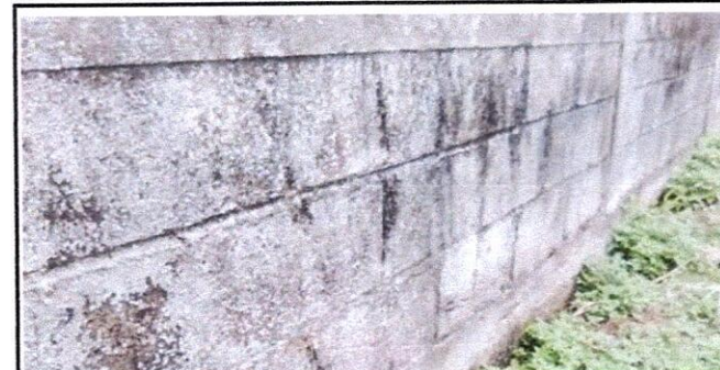
FOTO 6: Repello y sernido en muro interior y exterior de toda la pared.
