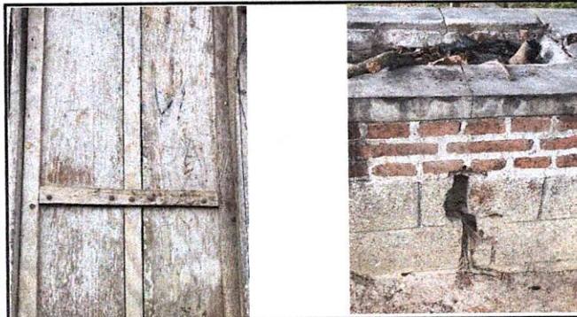
FOTO 3: Fabricación y colocación de 2 puertas de metal para sustituir las de madera, y sustitución de poyotón rural
