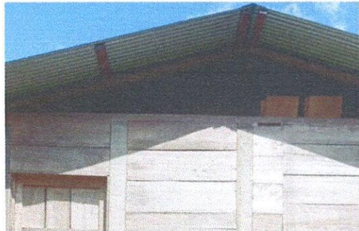
Foto 6: TECHO DE COCINA
