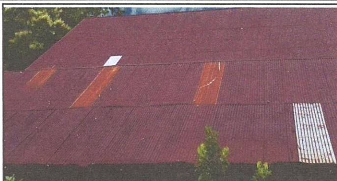
Foto 2: MODULO 1.Sustitución de lámina por lámina troquelada calibre 26
