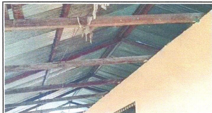
Foto 3: MODULO 1.Sustitución de estructura de madera por metal
