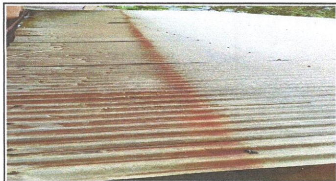
Foto 4: MODULO 2.Sustitución de lámina por lámina troquelada calibre 26
