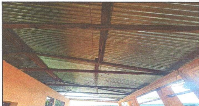
Foto 1: MODULO 1.Sustitución de lámina por lámina troquelada calibre 26
