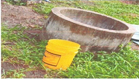
Foto 1: Mantenimiento de pozo artesanal a pozo mecánico con accesorios
