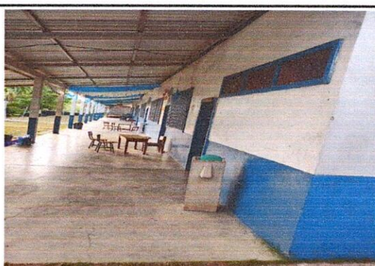
Foto 4: Vista frontal del establecimiento.
