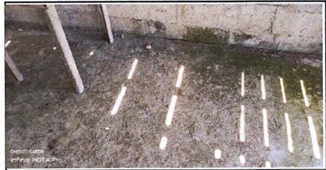
Foto 6: Sustitución de piso por torta de concreto.
