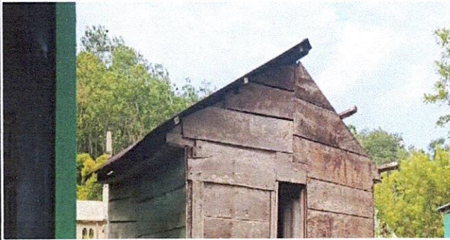
Foto1: CUBIERTA DE LAMINA
