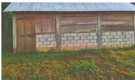
Foto 1: VISTA FRONTAL DE LA COCINA ESCOLAR.
