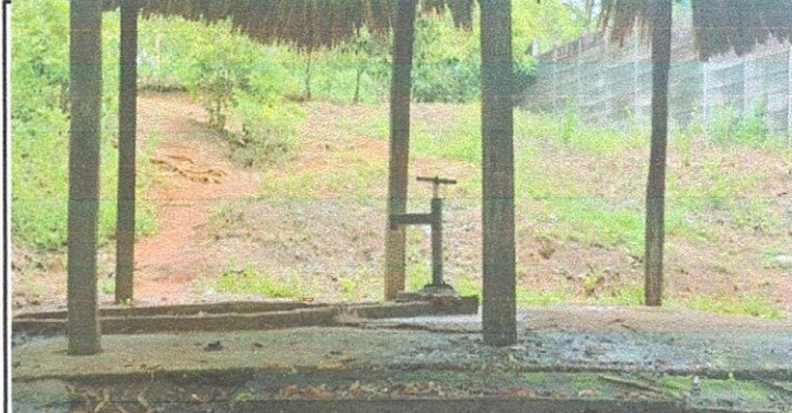
Foto 2: sustitución de bomba de agua
