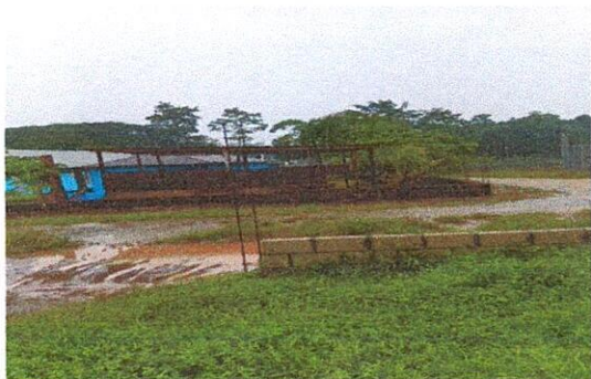
Foto1: Circulacion con malla
