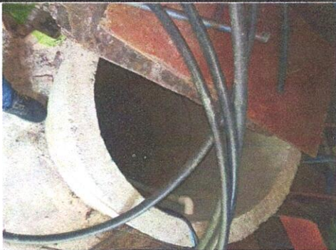
Foto 3: SUMINISTRO DE TUBERÍA PRINCIPAL Y SUS ACCESORIOS
