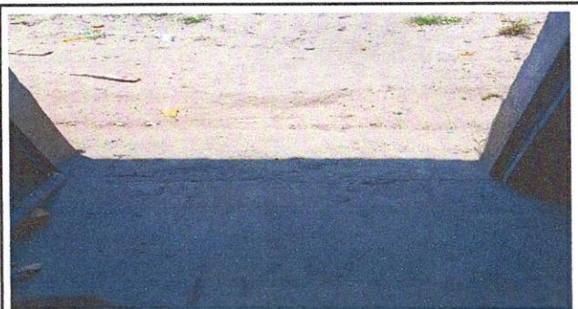
Foto 5: PISO DE SALIDA DE COCINA EN MAL ESTADO, POR LO QUE SE DEBE INALTAR LA TORTA DE CONCRETO, ASI EVITAR QUE CUANDO LLUEVA INGRESE LODO DENTRO DE LA COCINA
