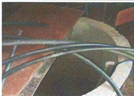
Foto 3: VISTA GENERAL DEL POZO A MEJORAR.
