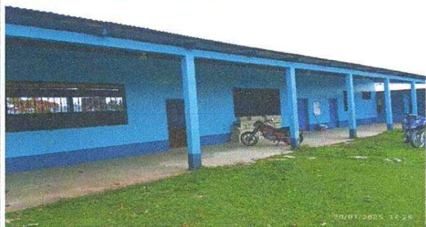
Foto 1: VISTA GENERAL DEL ESTABLECIMIENTO A INTERVENIR
