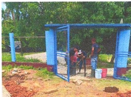
Foto 6: Sustitución de porton.
