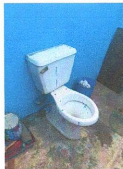
Foto 4: Sustitucion de sanitarios.
