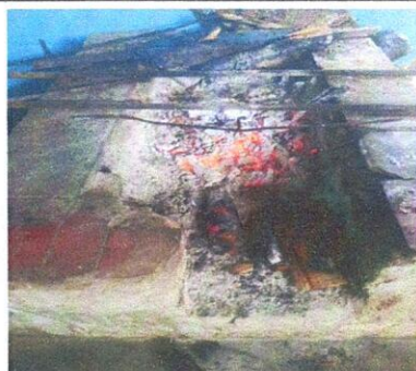
Foto 3: Reparación de estufa rural.
