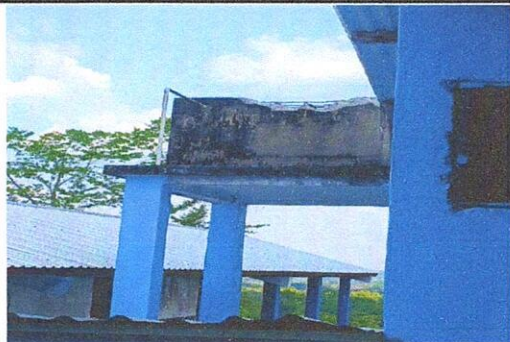
Foto1: Sustrucción de torre de metal para depósito de agua, el actual es de concreto y tiene aproximadamente mas de 30 años (esta quebrado).
