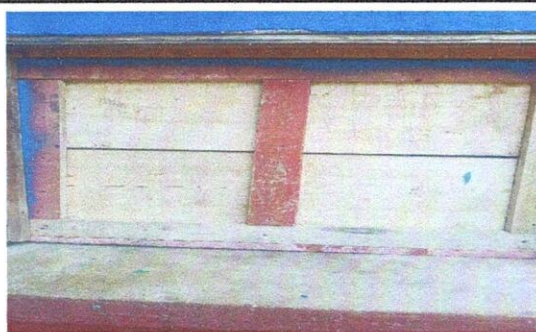
Foto 2: Sustrucción de ventana de madera por metal.
