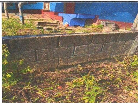
Foto 3: Aplicación de repello y pintura en muro de contención.
