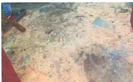
Foto 5: Sustitución de torta de concreto.
