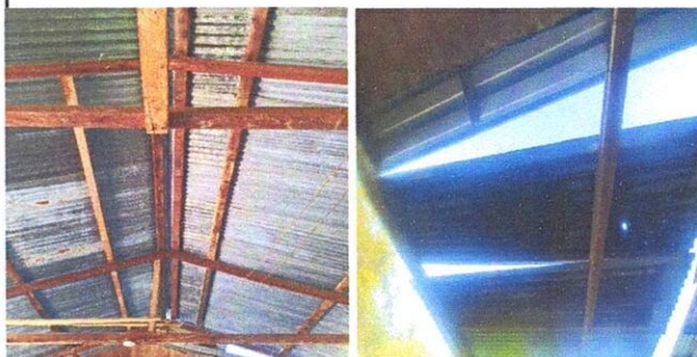
Foto 2: Sustitucion de estructura de madera en mal estado y láminas rotas.
