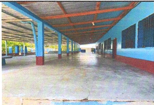
Foto1: VISTA GENERAL DEL ESTABLECIMIENTO Y SISTEMA ELECTRICO.
