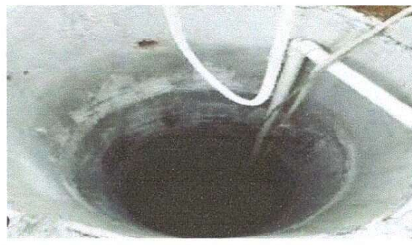
Foto 4: Vista dentro del pozo
