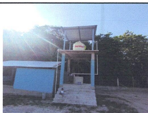
Foto 4: Vista completa del pozo artesanal con su torre, tinaco y techo, lo cual sería utilizado con el pozo mecánico.
