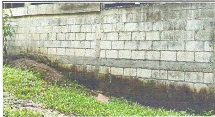
Foto 4: Pintura en muro sinteriores y exteriores
