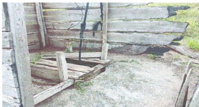
Foto 3: Vista general del pozo a mejorar.
