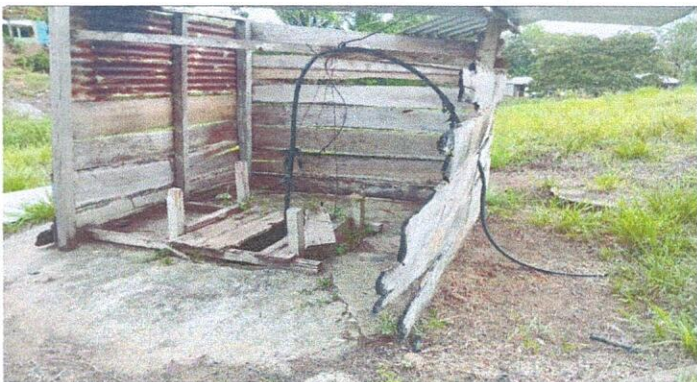
Foto 4: Necesidad de nueva tubería principal y accesorios.
