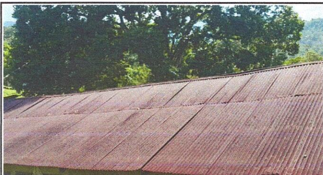
Foto1: DESCRIPCION. SUSTITUCION DE LAMINAS TROQUELADAS.
