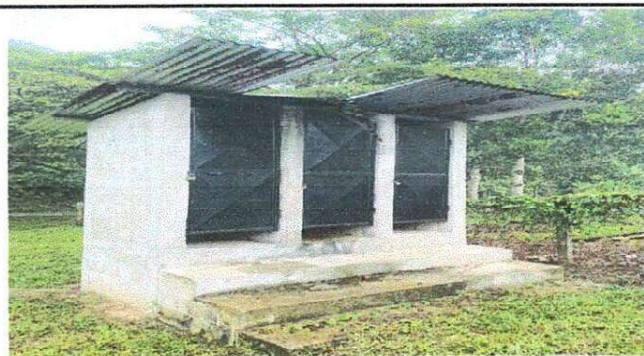
Foto 2: Sustitución de lámina de techo para baños
