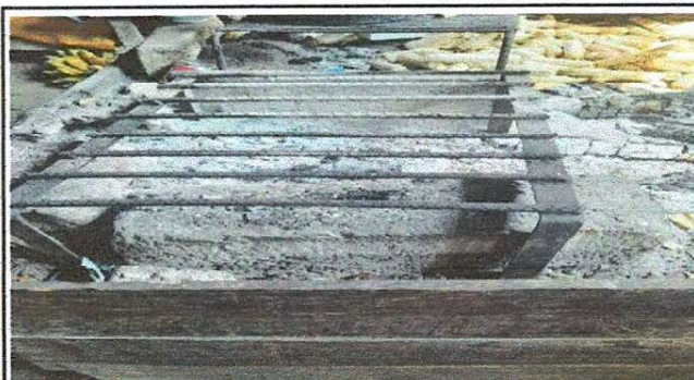
Foto 4: Sustitución de chimenea y plancha de metal
