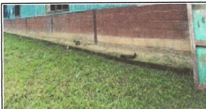
Foto 5: Sustitución de pared de block
