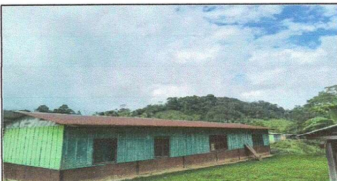
Foto 3: Sustitución de lámina de techo de la escuela
