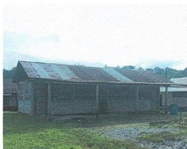
Foto 5: Sustrucion de capote de lámina para lámina troquelada.
