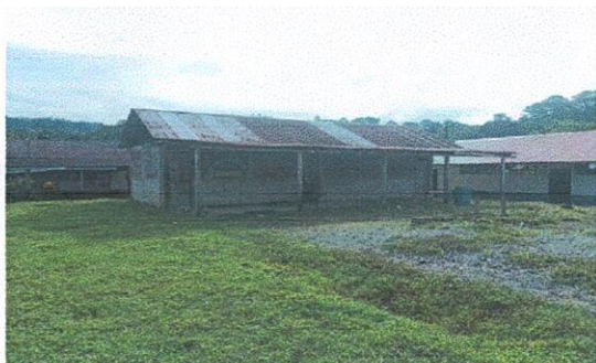
Foto1: Sustrucion de lámina, por lamina troquelada aluzinc calibre 26
