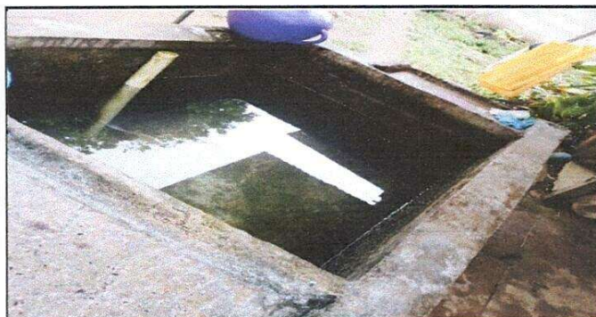
Foto 6: Sustrucción de Pila de cemento de dos lavaderos
