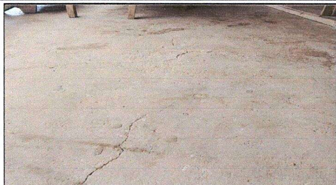
Foto 7: Reparación de piso de torta de concreto
