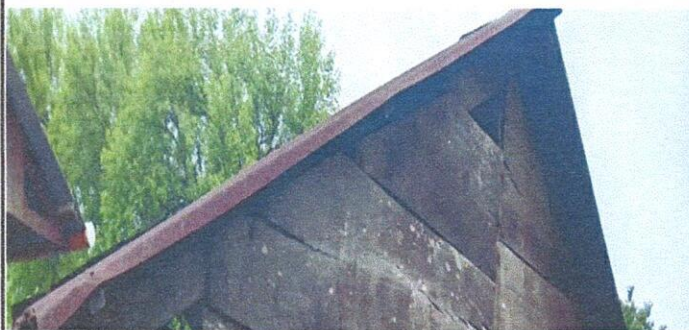
Foto 1: Cubierta de lámina. 1.1 Sustitución de lámina por lámina troquelada aluzinc calibre 26.
