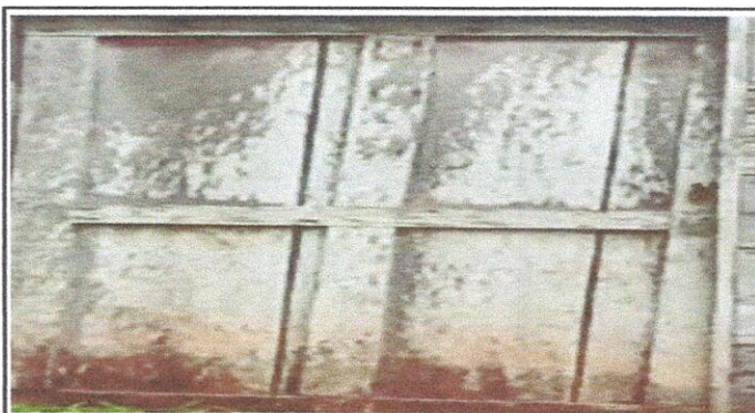
Foto 4: Ventanas. 4.1 Sustitución de ventanas de madera por balcones
