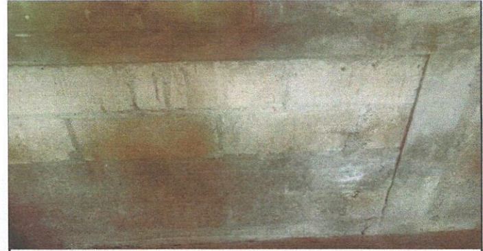
6. Repello en paredes (1 cm grosor)
