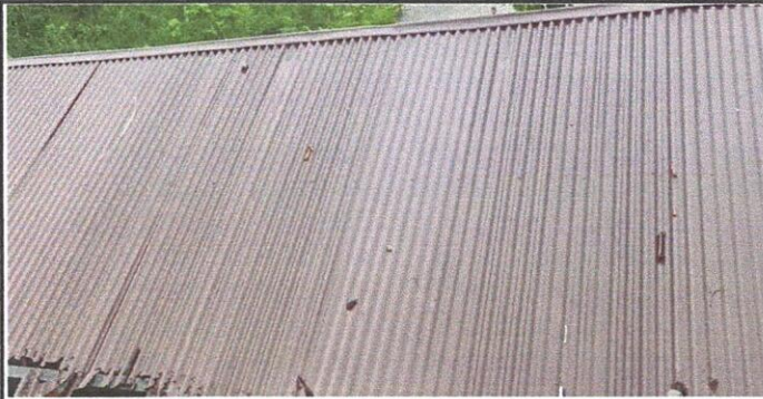
Foto 1: Sustrucción de lámina por lámina troquelada alizinc calibre 26.
