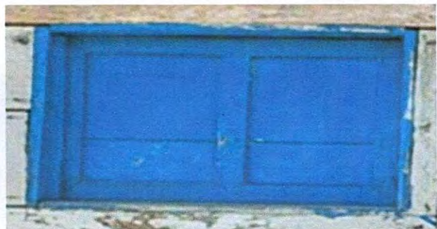
Foto 5: Sustitución de ventana de madera por metal.
