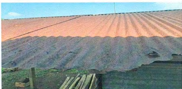
Foto 3: Sustitución de laminas por laminas troqueladas.
