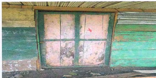
Foto 4: Sustitución de puertas
