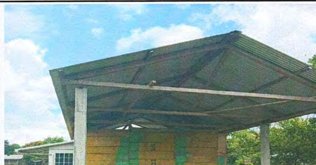
Foto 2: Sustitución de estructuras de madera por metal.
