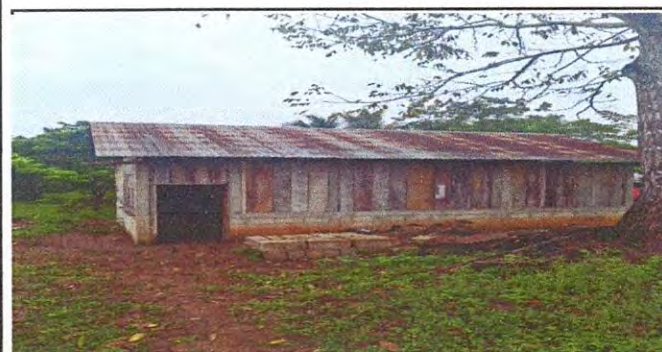
Foto 5: En este lugar quedara ubicado el pozo mecanico, muy cerca de la cocina.
