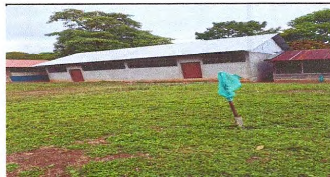
Foto 6: quedara ubicado dentro del predio de la Escuela aun costado de la cocina a 10 mts de las aulas.
