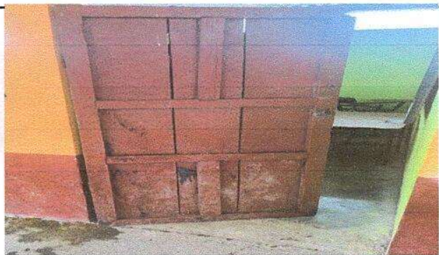
Foto 3: Sustrucción de puerta de madera por metal
