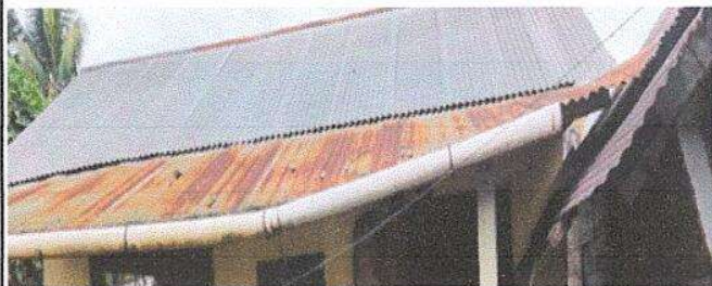
Foto 1: Sustrucción de lámina por lámina troquelada calibre 26
