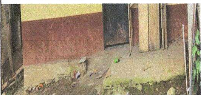
Foto 5: Sustrucción de piso de torta de cemento
