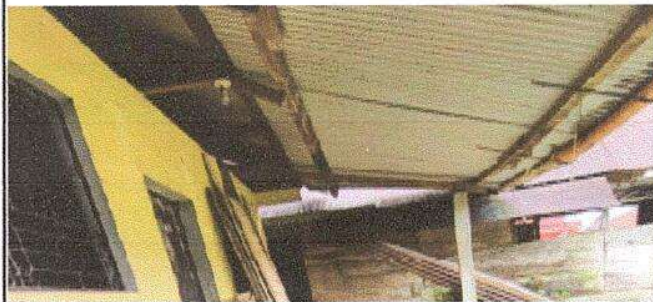
Foto 2: Sustrucción de estructura de madera por metal
