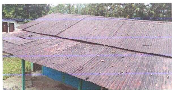
Foto 1 Sustrucción de lamina, por lamina troquelada
