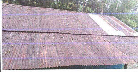
Foto 2: Sustrucción de capote de lamina para lamina troquelada
