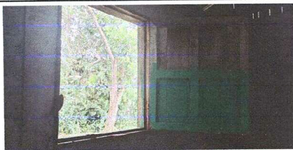
Foto 5: Sustrucción de ventana de madera por metal mas vidrio
