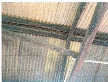
Foto 5: Estructura de soporte de techo de madera deteriorado a punto de caerse.
