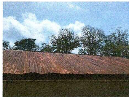
Foto 2: Vista del modulo con laminas antiguas, rotas y oxidadas.
