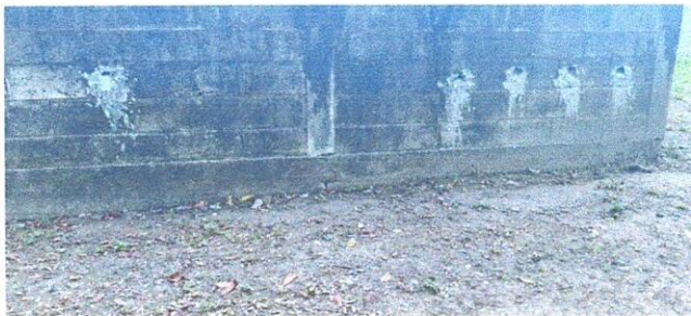
Foto 5: MURO DE CONTENCION CON NECESIDAD DE INTERVENCIÓN.
