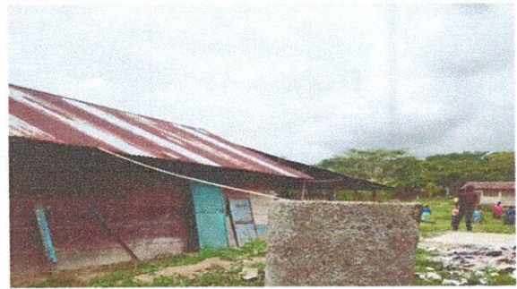
Foto 4: sustitucion de tubos en mal estado por suministro de tubería pvc
