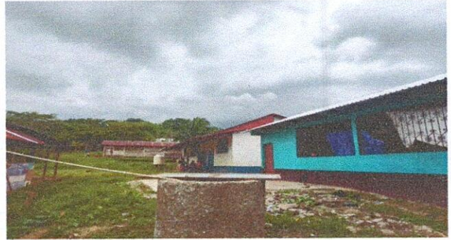
Foto 2: Intervenir por pozo mecanico
