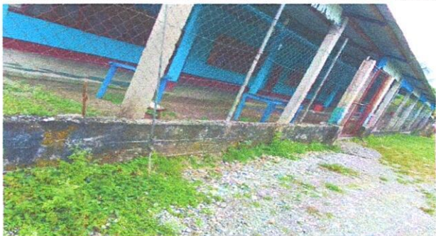
Foto 1: VISTA GENERAL DEL ESTABLECIMIENTO CON MURO PERIMETRAL
