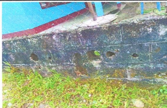
Foto 3: SUMINISTRO DE BLOK PARA PAREDES DE MURO PERIMETRAL.
