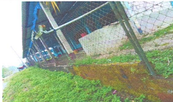
Foto 2: SUMINISTRO DE MAYA PARA MURO PERIMETRAL.
