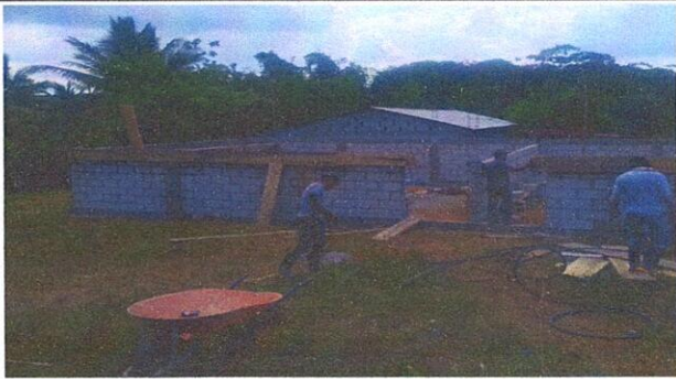
Foto 1 SUSTITUCION DE LAMINA TROQUELADA ALUZINC CALIBRE 26
