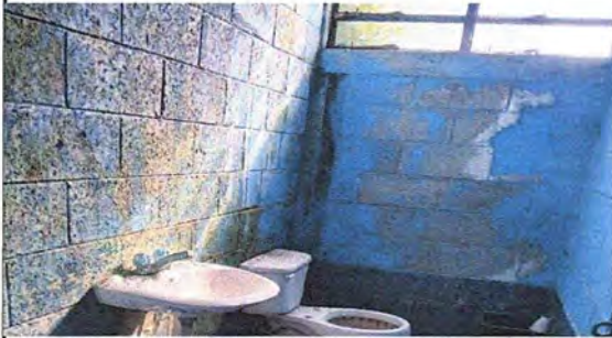
Foto4: MODULO 2 Repello , cernido de paredes e instalacion de azulejo
