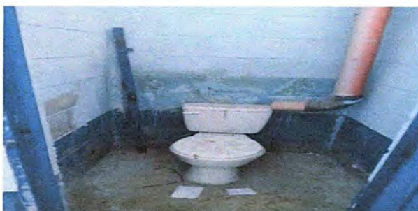
Foto 2: MODULO 2 Sustitucion de inodoro
