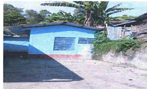
FOTO 7: MODULO 2. Pintura en interior y exterior
