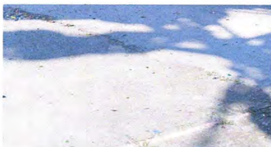
Foto 3: MODULO 1 Reparación de plancha de concreto de patio
