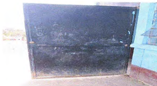
Foto 1: MODULO 2 . Sustitución de puerta de metal
