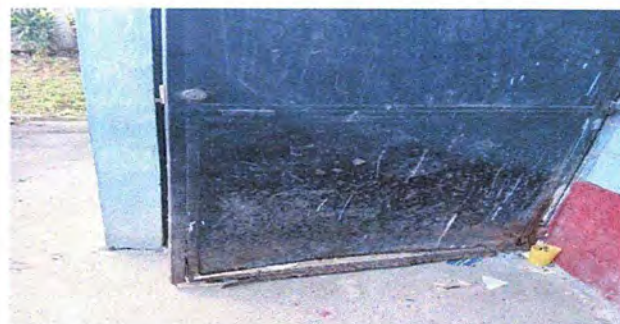
Foto 2: MODULO 1. Sustitucion de Puerta de metal
