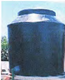
FOTO 6: MODULO 2 Sustitución de deposito de agua 1,110LT
