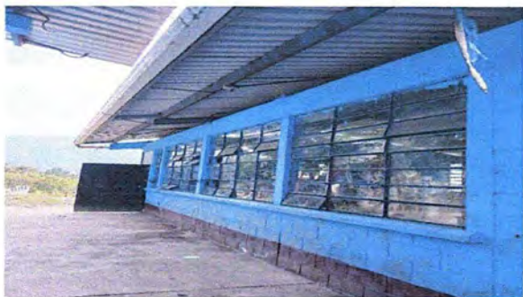
Foto1: MODULO 1 Suministro e instalación de balcones de hierro en ventanas.
