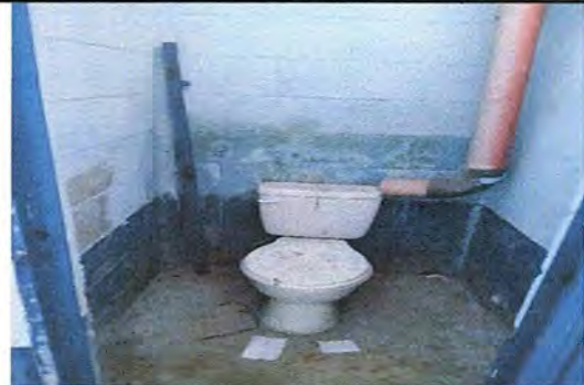
Foto 5: MODULO 2 Sustitución de piso de cemento líquido por piso cerámico
