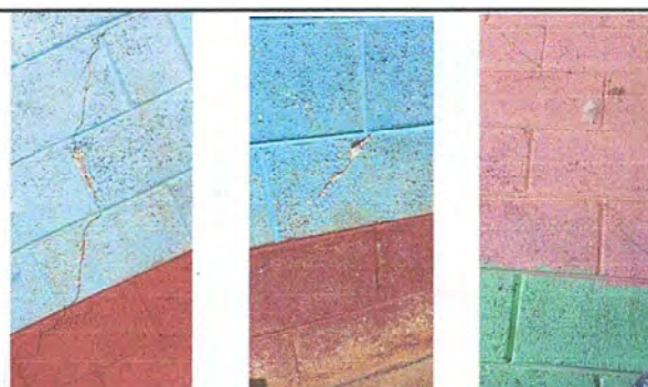
Foto 6: Módulo 1. Sellado de grietas y fisuras de pared de block
