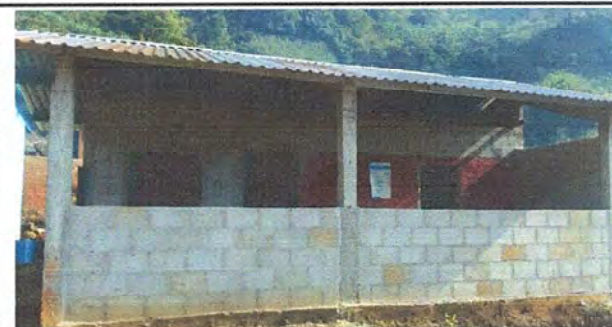
Foto 10: Módulo 4. Suministro e instalacion de balcones
