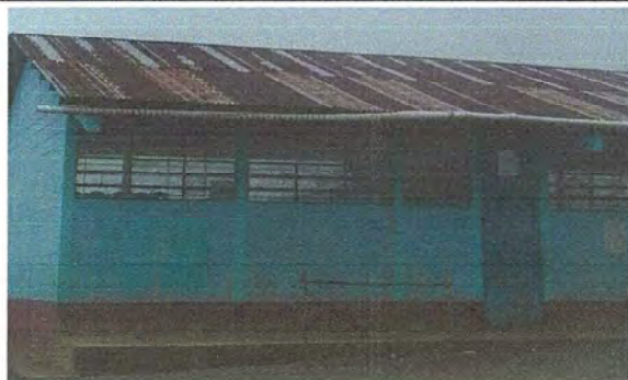
Foto 1: Módulo 1 Sustitución de canales PVC
