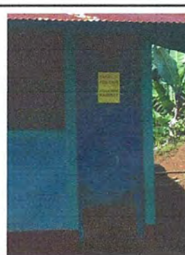
Foto 4: Módulo 1. Mantenimiento de puertas de metal
