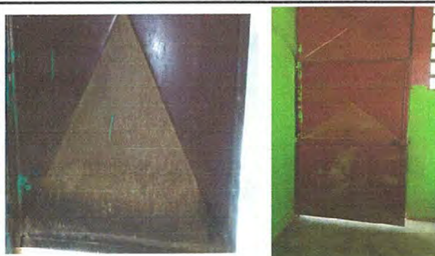
Foto8: Sustitución de puertas de metal
