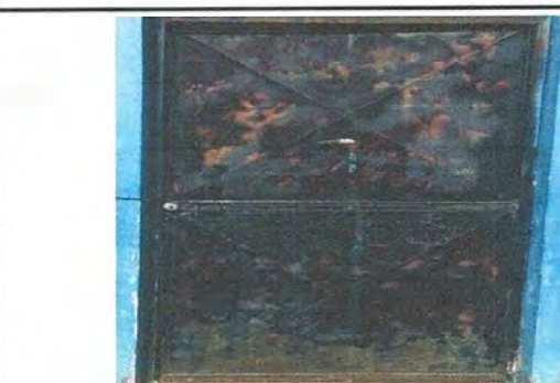
Foto 12: Módulo 4. Mantenimiento de estructura de puerta (lijado, cambio de tubo, cepillado, sujeciones, aplicación de pintura)
