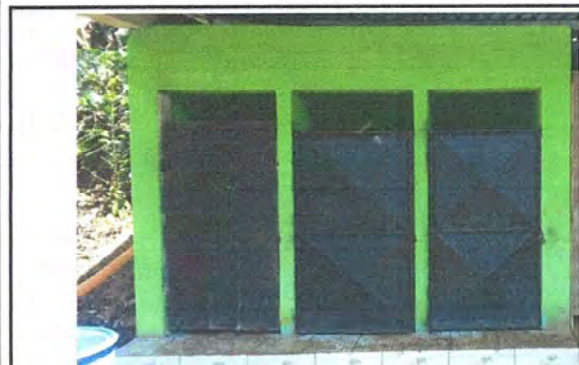
Foto 9: Módulo 3 Sustitución de puertas de metal para baños.
