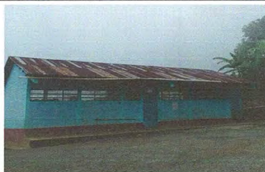
Foto 2: Módulo 1 Sustitución de lámina, por lámina troquelada aluzinc calibre 26
