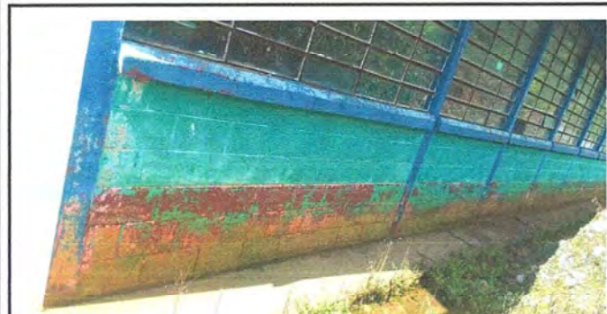
Foto7: Módulo 2 Repello de muro
