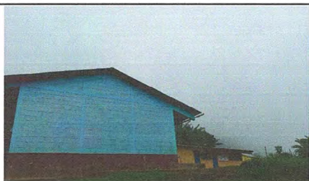
Foto 3: Módulo 1 Pintura de muro exterior e interior
