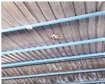
Foto 3: MODULO 1 Sustitución a estructura de soporte de metal
