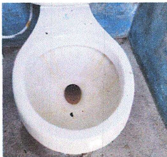
Foto 5: MODULO 2 Sustitución de inodoro
