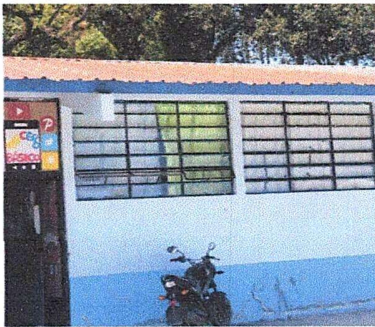
Foto1: MODULO 1 Pintura en muros de exteriores e interiores
