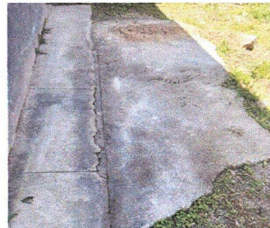
Foto 4: MODULO 1 Reparación planchas de concreto de patio
