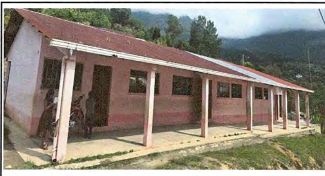
Foto 4: MÓDULO 1. PINTURA EN MUROS EXTERIORES E INTERIORES.
