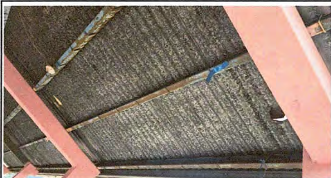
Foto 1: MÓDULO 1. SUSTITUCIÓN DE LÁMINA TROQUELADA Y MANTENIMIENTO A ESTRUCTURAS DE SOPORTE DE METAL.
