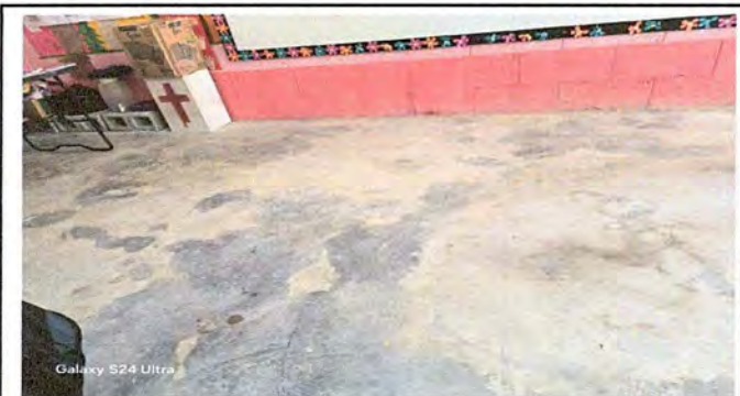
Foto 3: MÓDULO 1. REPARACIÓN DE PISO DE TORTA DE CONCRETO POR PISO CERÁMICO.
